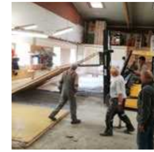
Kauf & Umbau des Firmengebäudes Wo eben noch gepackt wurde wird alles abgebaut und für den neuen Betonboden vorbereitet. Wir sanieren Böden, Wände, Dach, Fassade, Heizungsanlage und vieles mehr.
